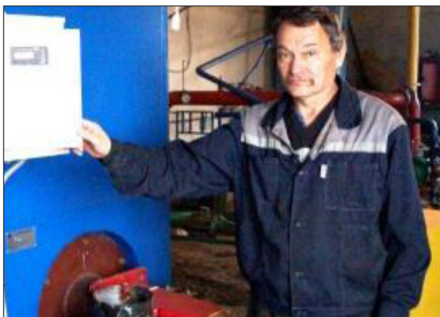
Оператор котельной Сергей Шульгин следит за стабильной подачей тепла.
