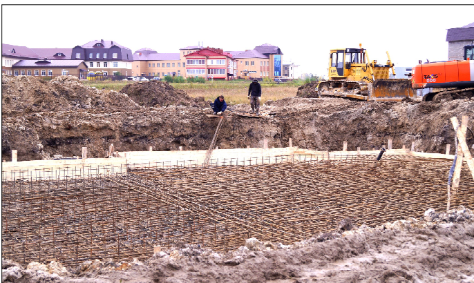
Начальный этап строительства.
