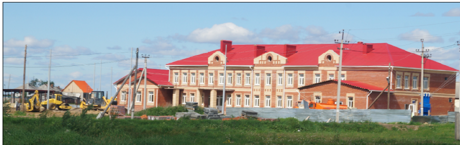
В Солянке достраивается новая школа с блоком дошкольного отделения.
