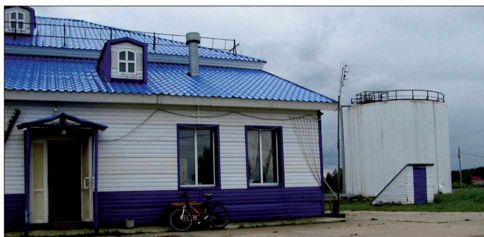
Здание станции водоочистки, на заднем плане резервуар чистой воды.
