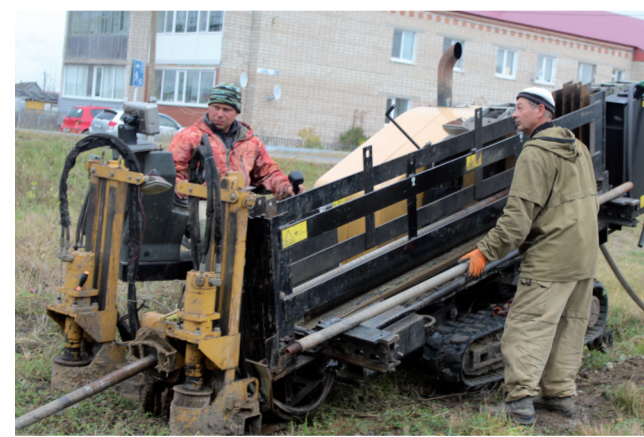
Установка ГНБ за работой.
