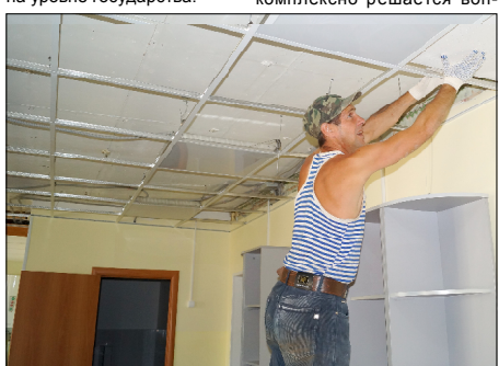
Монтаж подвесных потолков.
