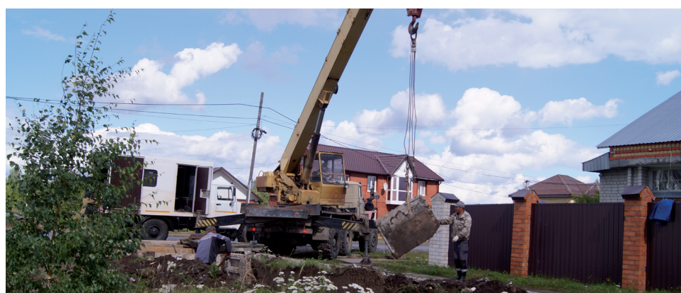
Летний ремонт теплотрассы.
