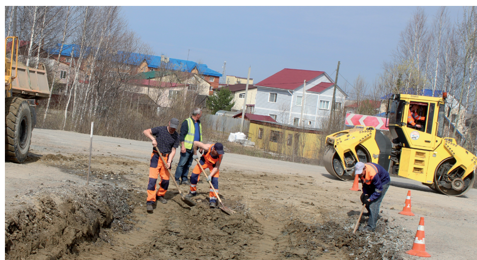
Идёт подготовка для укладки асфальтобетона.
