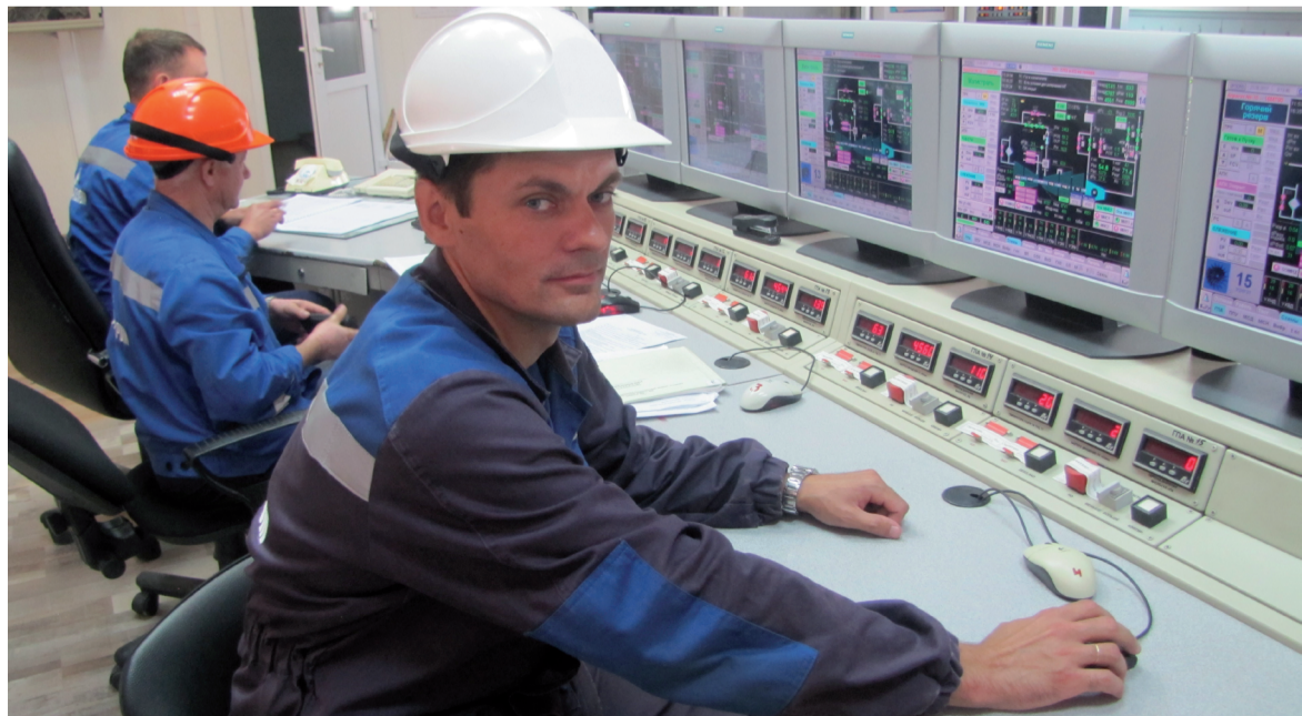
Инженер КИПиА Виталий Нестеров.
