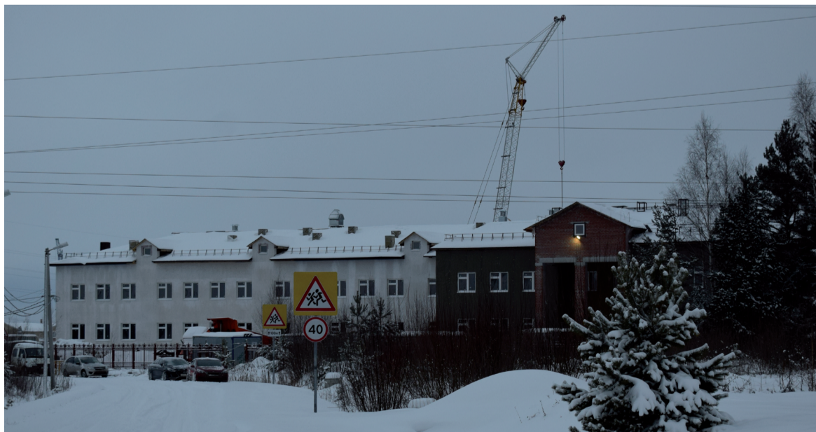
Строительные работы на Уватской школе ведутся по графику.
